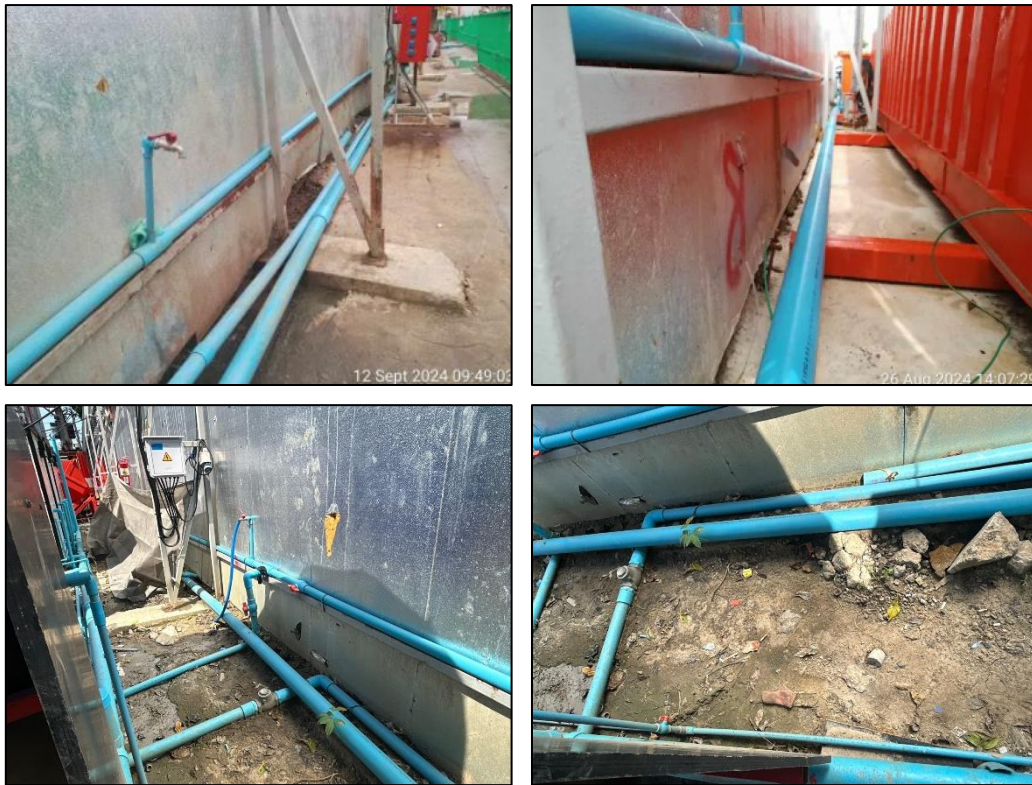
รูปที่ 1-6 ท่อระบายน้ำชั่วคราวรอบบริเวณพื้นที่โครงการ
