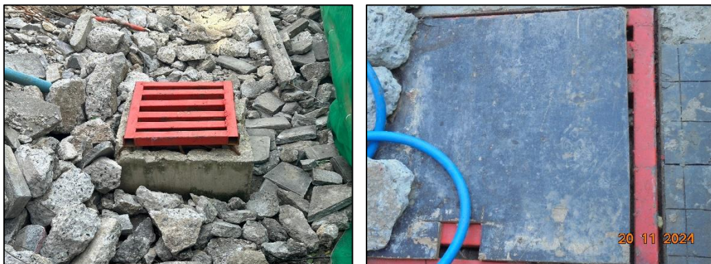
รูปที่ 1-7 ตะแกรงดักขยะบริเวณปากท่อระบายน้ำ
