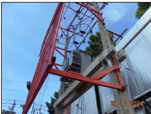
รูปที่ 1-10 หม้อแปลงไฟฟ้าก่อสร้างโครงการ
