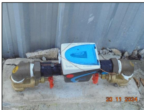
รูปที่ 1-5 ติดตั้งมิเตอร์น้ำประปาภายในพื้นที่โครงการ
